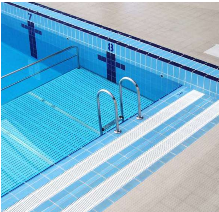
Detalle de piscina deportiva / Sports pool detail Borde Finlandés / Finnish edge
